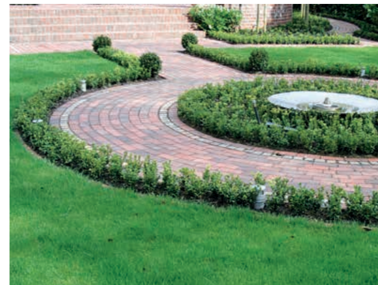
Abb. A5-9: Mit Rechteckklinkern verlegter Bogen. Die Rand- und Passsteine müssen passend zugeschnitten werden
