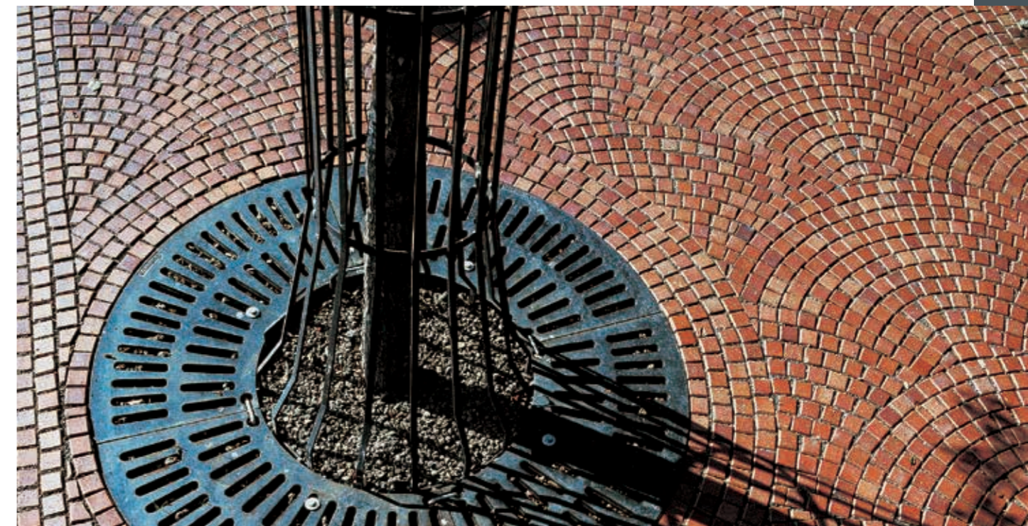
Einfassung von Einbauten mit Mosaikklinkern (Segmentbogenpflaster)
