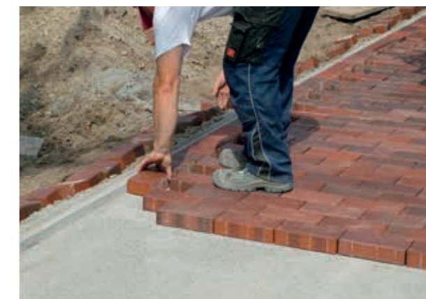
Abb. 5-11: Handverlegung von Pflasterklinkern
