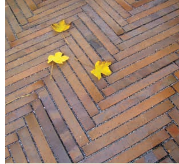
Pflasterklinker als Langformat verlegt im Fischgrätverband
