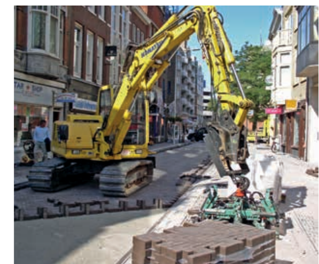
Maschinenverlegung von Pflasterklinker, Den Haag, Niederlande
