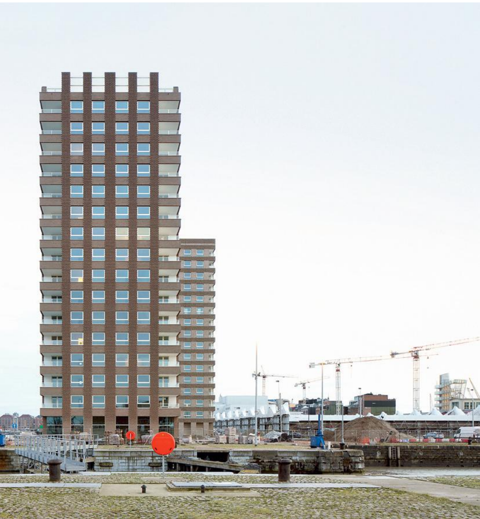
▲ Die Wohnhochhäuser in Antwerpens Hafen sind keine starren Blöcke mehr, sondern offene Gebäude. Ihre Grundform entwickelt sich über die Eckbalkone nach außen.
