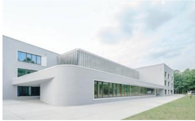
▲ Das hellgrau geschlämte Sichtmauerwerk unterstützt die Klarheit der Architektursprache.
