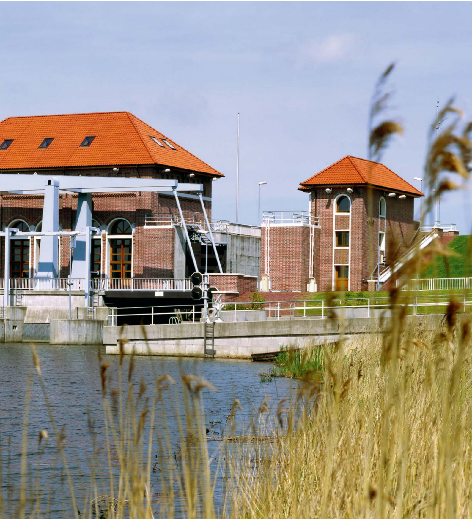
Sielbauwerk an der Maade Wilhelmshaven Bockhorner Bunt 04 Glatt OF
